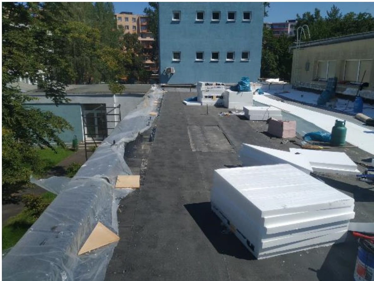
Práce na rekonstrukci střechy
